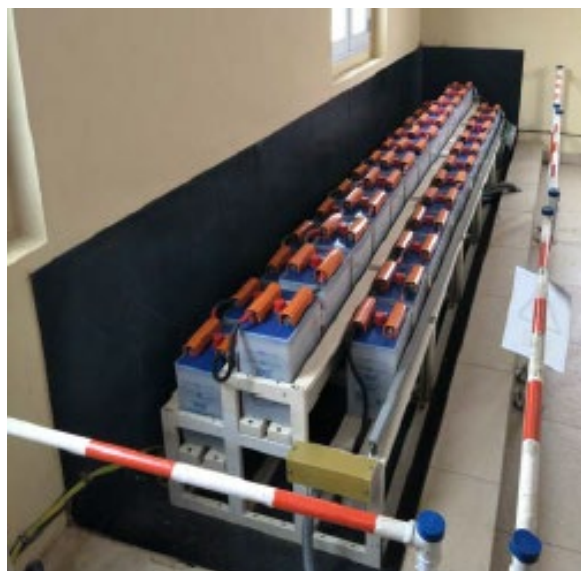
Figure 1: Espace d'entreposage des batteries
